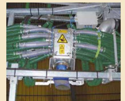
Hacheur répartiteur vertical avec coupure pneumatique de tronçons
